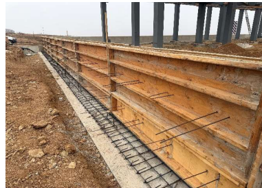
Cimbrado de pretil.
