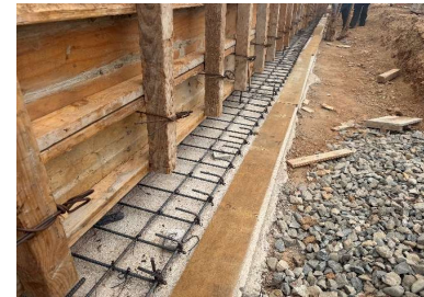
Colocación de frontera para zapata corrida.
