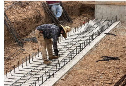
Armado de acero para barda en patio de servicios.
