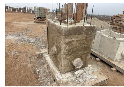
Descimbrado de registros pluviales.
