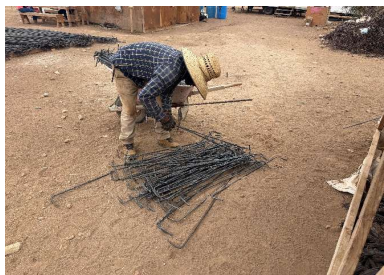
Habilitado de acero para zapata corrida.
