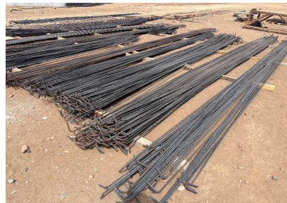
Habilitado de acero para firme.
