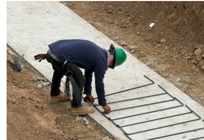
Colocación de acero en contratrabe.
