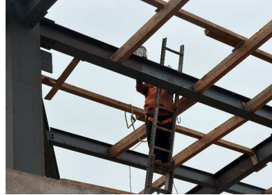
Aplicación de primer a estructura metálica.
