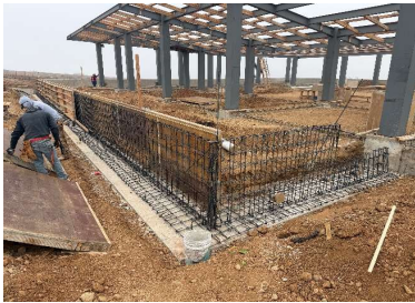
Habilitado de acero para desplante de barda.
