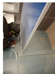
REPARACION DE CERAMICA QUEBRADA EN SARDINEL DEL SANITARIO DE NIÑOS
