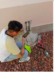
REPARACION DE CERAMICA QUEBRADA EN SARDINEL DEL SANITARIO DE NIÑOS
