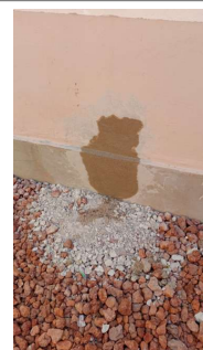
SE REPARO TAPON EN DESCARGA SANITARIA DE LAVABO DE AREA DE INICIAL 3
