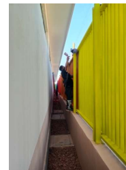
REPARACION DE CERAMICA QUEBRADA EN SARDINEL DE REGADERA DEL AREA DE CONTROL DE ESFINTERES Y SE CONTINUA PINTANDO DETALLES FALTANTES DE LA REJA PERIMETRAL
