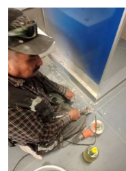
REPARACION DE CERAMICA QUEBRADA EN SARDINEL DEL SANITARIO DE NIÑOS
