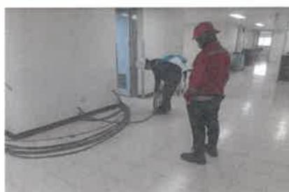
SE REALIZA LA PREPARACIÓN DE LOS CONDUCTORES ELÉCTRICOS DE LA CEDULA 7 PARA INSTALAR EN CHAROLA EN PISO 7 DE ESPECIALIDADES
