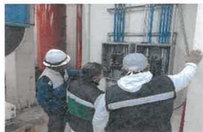
REVISIÓN DE LA CORRECTA INSTALACIÓN DE ALIMENTADORES EN TABLEROS ELÉCTRICOS EN PLANTA BAJA DE LA NUEVA CENTRAL.
