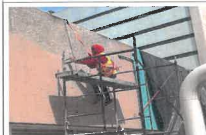
SE CONTINUA CON EL RETIRO DEL APLANADO EN MAL ESTADO EN MUROS INTERIORES DE LA TERRAZA EN SEGUNDO NIVEL DE LA NUEVA CENTRAL.
