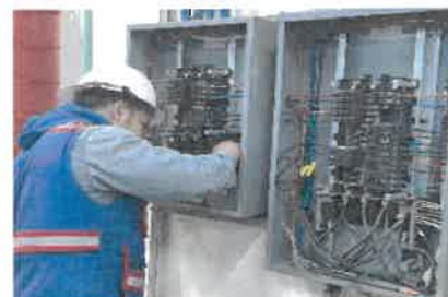
TRABAJOS DE IDENTIFICACIÓN DE CIRCUITOS EN TABLEROS ELÉCTRICOS DE PLANTA BAJA DE LA NUEVA CENTRAL.
