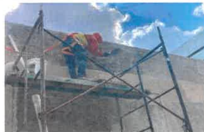
APLICACIÓN DE APLANADO EN MUROS INTERIORES DE LA TERRAZA DE LA PLANA ALTA DE LA NUEVA CENTRAL
