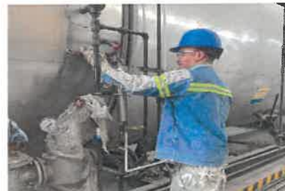
TRABAJOS DE HABILITADO E INSTALACIÓN DE DREN DE FILTRO DE ELECTRO LAVADO EN CALDERAS 1 Y 2 PLANTA BAJA DE LA NUEVA CENTRAL.
