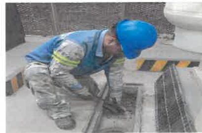
SE REALIZA LA LIMPIEZA Y DESAZOLVE DE LA COLADERAS UBICADA EN INTERIOR DE LA PLANTA BAJA DE LA NUEVA CENTRAL DE SERVICIOS
