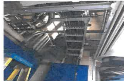
TRABAJOS DE CONTINUIDAD DE MODIFICACIÓN DE CHAROLA ELÉCTRICA EN PISO 7 DEL HOSPITAL DE
