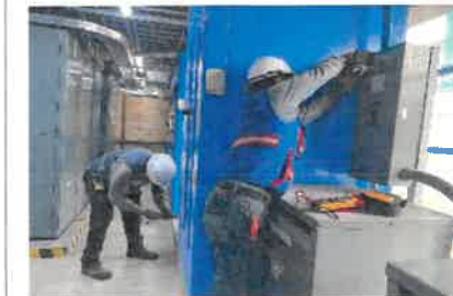
TRABAJOS DE CIERRE DE TABLEROS ELÉCTRICOS EN PLANTA BAJA DE LA NUEVA CENTRAL DE SERVICIOS.
