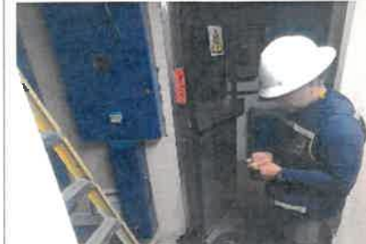
SE REALIZA LA MODIFICACIÓN DE LA CHAROLA ELÉCTRICA EN CTO. ELÉCTRICO DEL PIO 7 DEL HOSPITAL DE ESPECIALIDADES.
