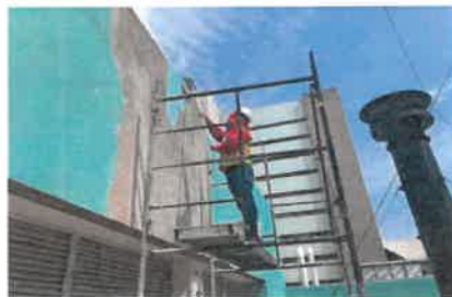
APLICACIÓN DE IMPERMEABILIZANTE A MUROS REPARADOS EN APLANADO EN TERRAZA PLANTA ALTA DE LA NUEVA CENTRAL DE SERVICIOS.
