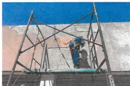
SE CONTINUA CON EL RETIRO DEL APLANADO DAÑADO EN MUROS INTERIORES DE TERRAZA DE LA NUEVA CENTRAL DE SERVICIOS
