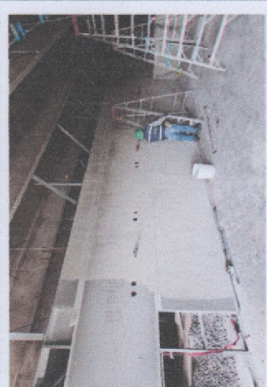
Trabajos de colocación de muros de tablacemento en área Postquirúrgica de Adultos correspondientes al Nivel 3
