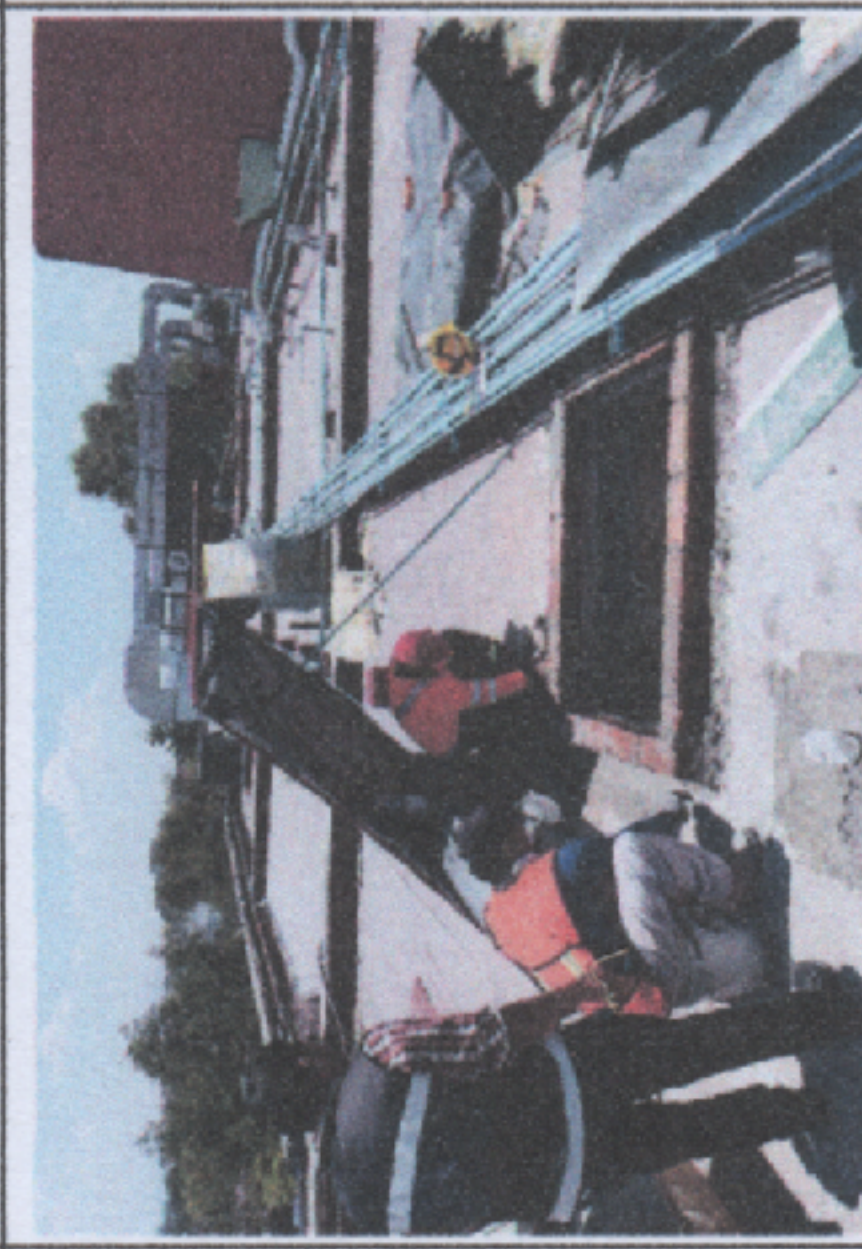
Trabajos de colocación de soportería para plafond en área Postquirúrgica de Adultos correspondientes al Nivel 3
