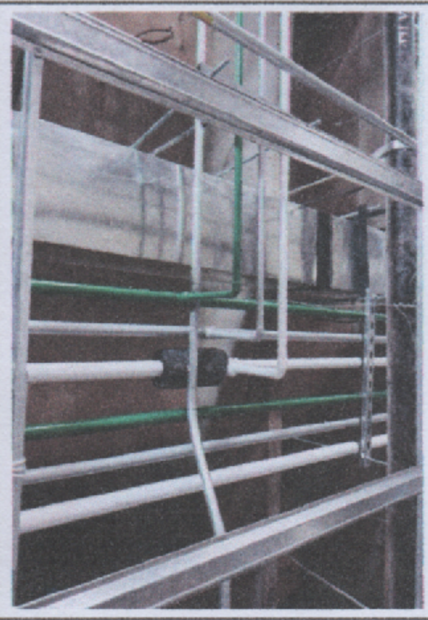
Trabajos de Instalación de líneas de gases medicinales correspondientes a las redes de distribución del proyecto del Nivel 3
