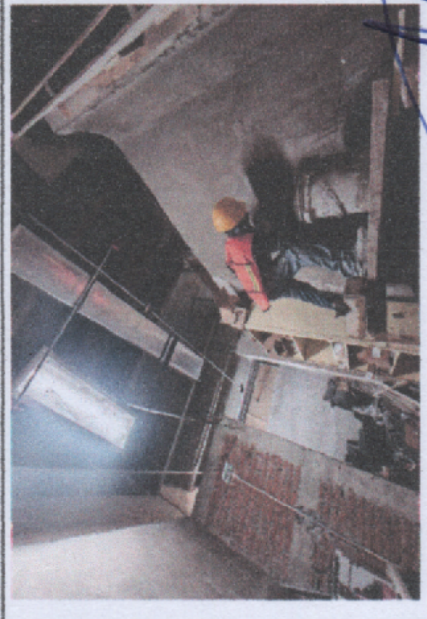
Instalación de ductos de aire acondicionado, tubería eléctrica, charofill telecomunicaciones y bajadas de agua pluvial en el Área Postquirúrgica de Pediátricos.
