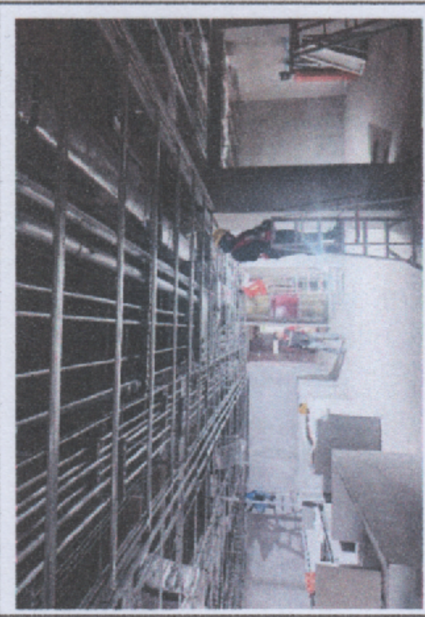
Trabajos de colocación de soportería para plafond en área Postquirúrgica de Adultos correspondientes al Nivel 3
