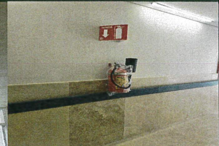
COLOCACION DE EXTINGUIDORES
