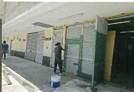
PINTURA EN PUERTAS LOUVER DE CASA DE MAQUINAS
