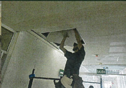
FABRICACION DE REGISTROS DE INSTALACIONES EN PLAFON CUERPO 2 ENCAMADOS ADULTOS
