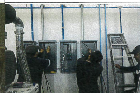
INSTALACION ELECTRICA CABLEADO DE INTERRUPTORES CASA DE GASES MEDICINALES
