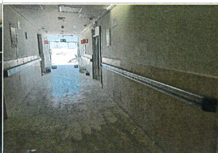
COLOCACION DE PROTECCION CONTRACAMILLA CUERPO 2 PASILLO DE ENCAMADOS ADULTOS
