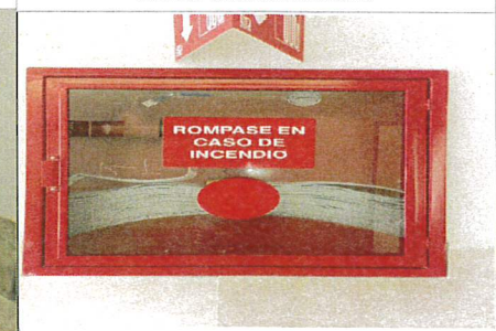
INSTALACION DE MANGUERAS DE HIDRANTES
