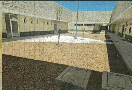
CUBRESUELOS CON PIEDRA ROJA Y BLANCA Y JARDINERIA EN CUERPO 1 CASA DE MAQUINAS
