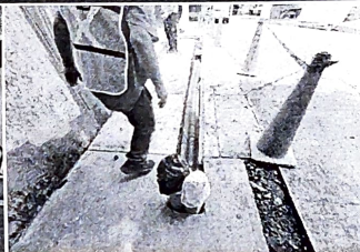
TENDIDO DE TUBO PAD NUEVA ACOMETIDA.
