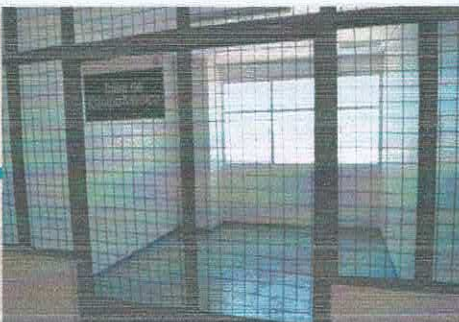
Colocacion de pintura epoxica en talleres de conservacion.
