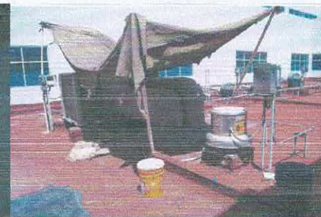
Trabajos en equipos de aire acondicionado.
