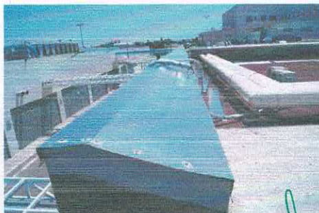
Trabajos de colocacion de flashing
