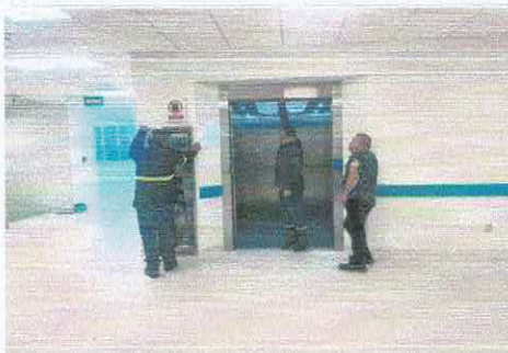
Trabajos en elevadores.
