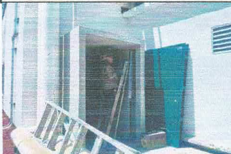
Trabajos en salida hacia azotea en primer nivel.
