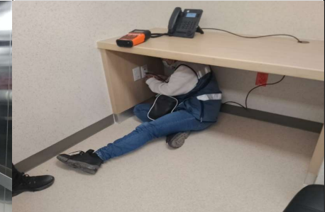
Colocación de tapas en salidas.
