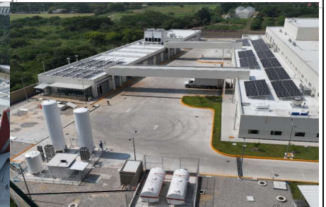
Limpieza fina de la obra.
