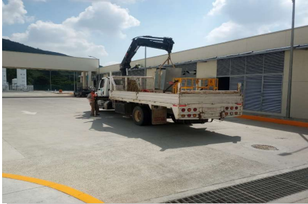
Limpieza general del sitio de los trabajos.
