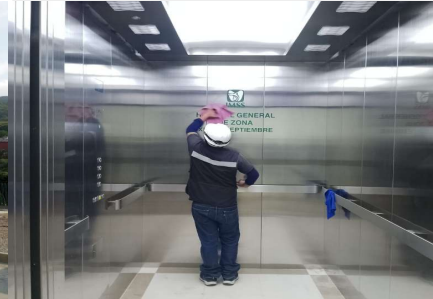
Limpieza fina de la obra.
