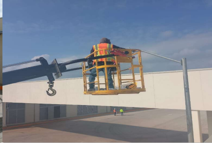
Sustitución de baterías de luminarias.
