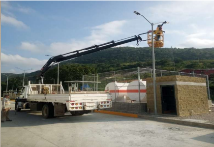
Sustitución de baterías de luminarias.
