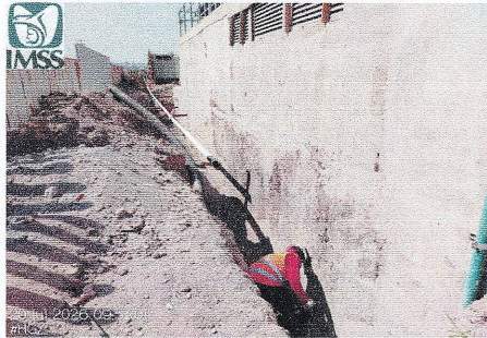
TENDIDO Y SOLDADURA DE TUBERÍA DE ACERO AL CARBON, EN ZONA DE PTAR HACIA CASA DE MÁQUINAS
