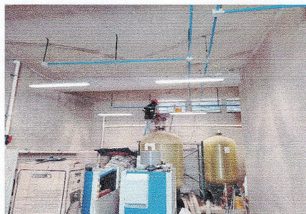
PERFORACIÓN DE MURO PARA PASO DE TUBERIAS DE CONEXIÓN DE PTAR HACIA CASA DE MÁQUINAS
