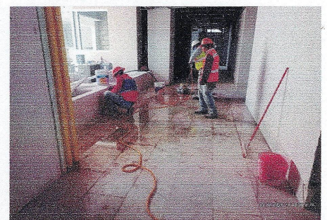
PULIDO DE PISO DE MÁRMOL FRENTE A SALA DE DILATACIÓN, NIVEL 1 EDIFICIO 5
