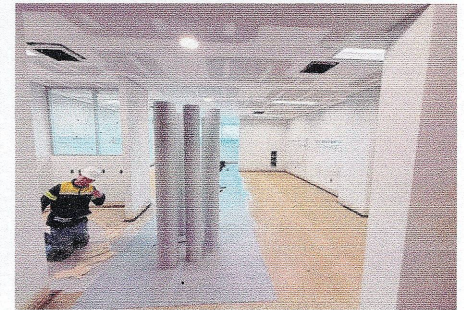
COLOCACIÓN DE PISO VINÍLICO EN ÁREA DE HOSPITALIZACIÓN, SEGUNDO NIVEL
