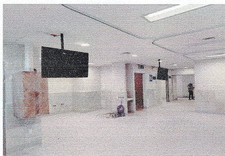
COLOCACIÓN DE PANTALLAS EN ÁREA DE DIÁLISIS, NIVEL 3
