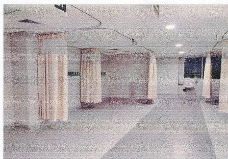
COLOCACIÓN Y ACOMODO DE CORTINAS EN ÁREA DE HOSPITALIZACIÓN DE MEDICINA INTERNA, NIVEL 3
