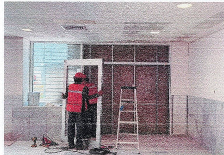
SUMINISTRO Y COLOCACIÓN DE PUERTAS DE ALUMINIO EN ÁREA DE COMEDOR, PLANTA BAJA
