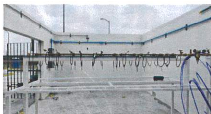
Ins. de cabezal para tanques de oxigeno area de tanque thermo edificio "D"
