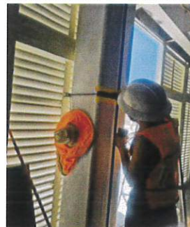
Pintura en Tubería de Subestación
