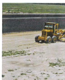
Nivelación de Terreno hacia pozos de absorción
