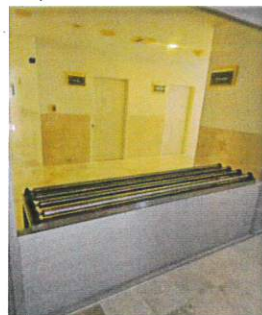
Instalacion de Rodillos en transfer de tocirugia
