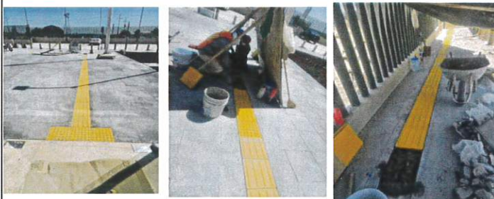
INSTALCION DE PISO PODOTACTIL
