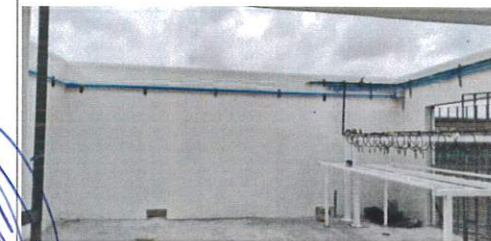
Pintura general en area Tanque Thermo Edif "D"
