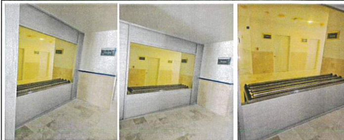
INTALACION DE RODILLOS PARA TRANSFER DE TOCOCIRIGIA
