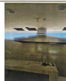
Inst. de campanas extractoras en cocina
