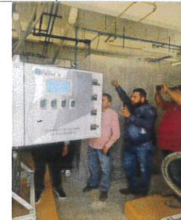
pruebas de equipos de gases mdicinales
