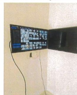
Instalacion de televisores CCTV
