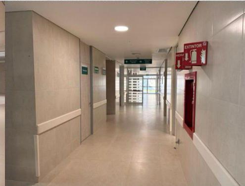
PASILLO TÉCNICO URGENCIAS
