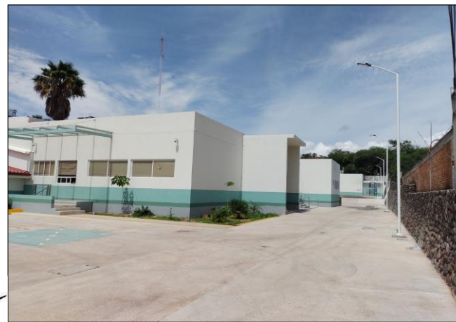
Area Exterior paso a servicios
