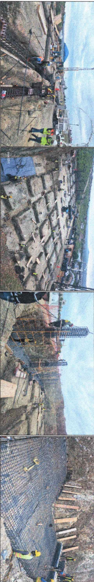
Excavación para Contratraves y descabece de pilas en edificio C
