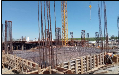
Trabajos de Cimbrado y armado de la losa del cuarto de equipos del edificio "A".
