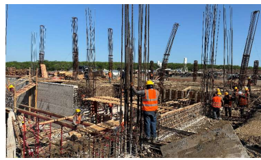
Trabajos de Cimbrado de trabes de la losa de entrepiso del primer nivel del edificio "A".
