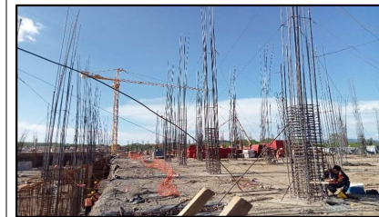
Trabajos de Relleno compactado de dados y trabes de
