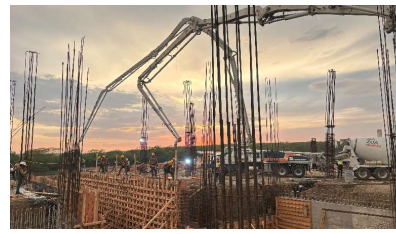
Colado de muros de contención en cuartos de equipos edificio "A" con concreto F'c 350 kg/cm2, tiro con bomba
