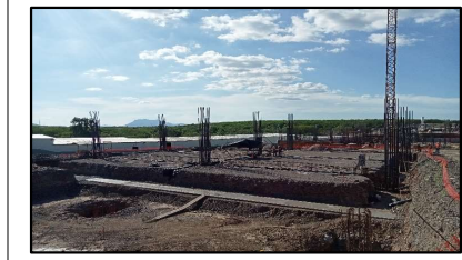
Trabajos de Habilitado y armado de acero de refuerzo para dados y trabes de cimentación del edificio "G".
