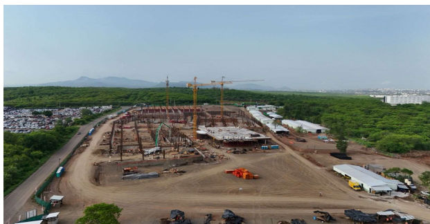
VISTA PANORAMICA FACHADA POSTERIOR
