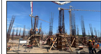
Trabajos de colados para columnas del edificio "F".
