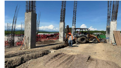
Trabajos de excavación de ramales en instalaciones sanitarias del edificio "D1".
