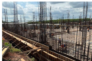
Trabajos de habilitado de cimbra para muro de contención de edificio "F".
