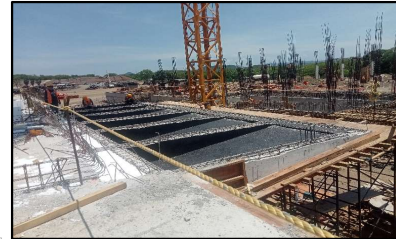
Trabajos de impermeabilizado en volados de azotea con
