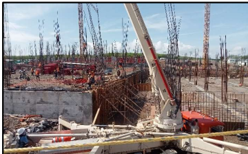
Trabajo de colado en muro de contención del edificio "C".
