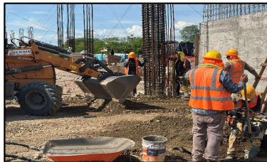
Trabajos de Relleno, compactación de dados y trabes de del edificio "D2".
