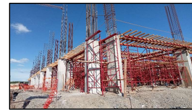
Trabajos de Cimbrado de trabes de la losa de entrepiso del primer nivel del edificio "E".
