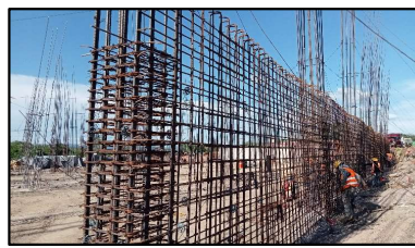
Trabajos de Habilitado y armado de acero de refuerzo de muro de contención
