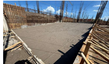
Colado de base de rampa en edificio "D1" con concreto F'c 150kg/cm2
