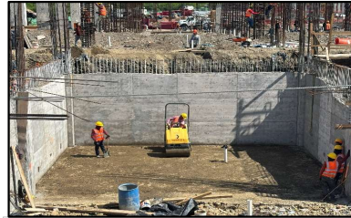
Trabajos de nivelación y compactación en firme de equipos del edificio "A".
