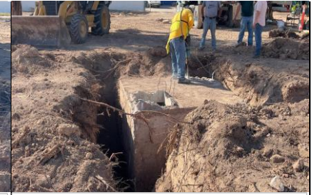
Demolición de estructura de concreto.
