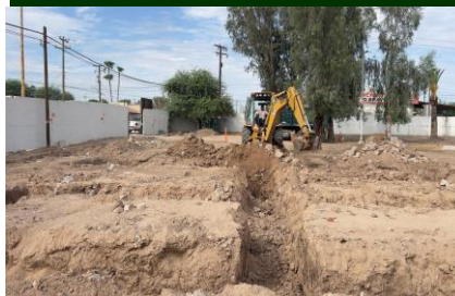
Excavación para cimentación.
