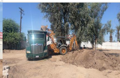
Retiro de material de corte y excavación.
