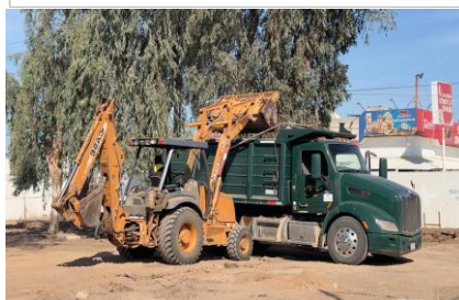
Retiro de material de corte y excavación.
