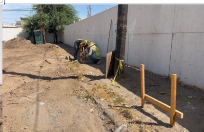
Colocación de guías para trazo de ejes.
