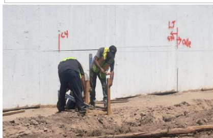
Colocación de guías para trazo de ejes.
