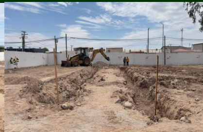
Excavación para cimentación.
