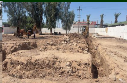
Excavación para cimentación.
