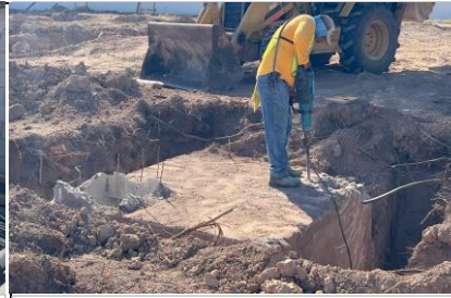
Demolición de estructura de concreto.
