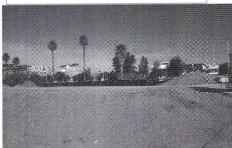
vista general de la plataforma fachada posterior.
