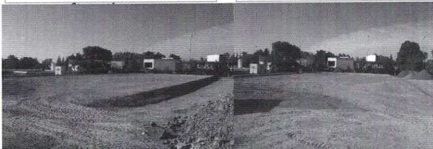
vista general de los ejes 1 y A
