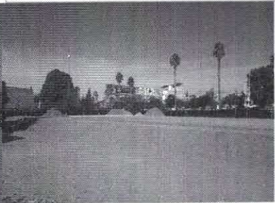
vista general de la plataforma fachada posterior.
