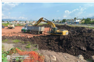
Excavación y retiro de material para conformación de
