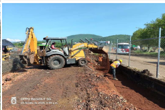
Colocación de filtro para nivelar superficie en zanja para desplante de barda perimetral lado Sur.
