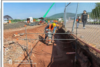
Compactación en zanja para desplante de barda perimetral lado Sur.
