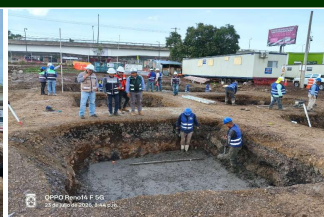
Colocación de plantilla concreto f'c= 100 kg/cm2 para
