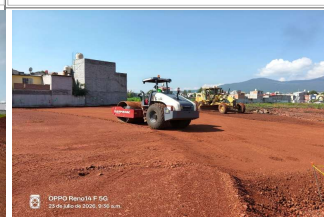
Compactación de material para conformación de cuerpo
