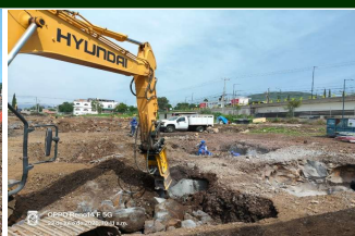
Excavación y Limpieza manual de material tipo III para
