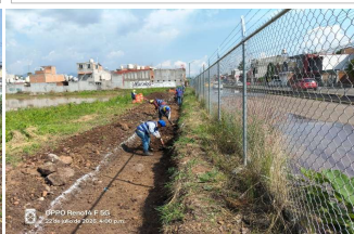
Excavación en zanja para desplante de barda perimetral
