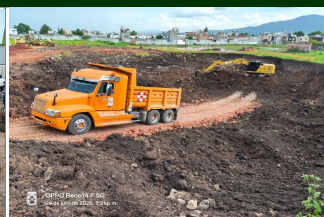
Excavación y acarreo para cimentación del Cuerpo A.
