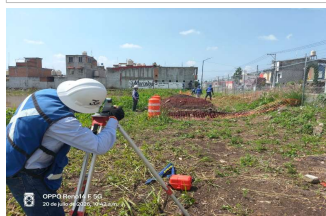
Excavación y nivelación en zanja para desplante de barda perimetral lado Sur-Este.
