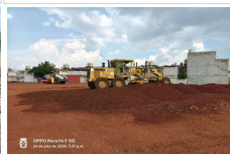
Conformacion de cuerpo del terraplen lado Sur-Este.
