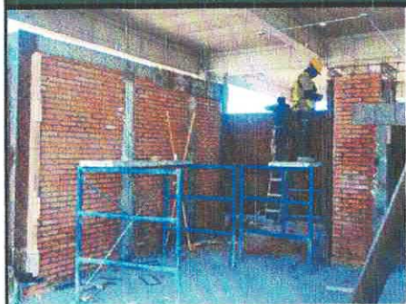
DESPLANTE DE MUROS DE TABIQUE ROJO PB EDIF. "D"
