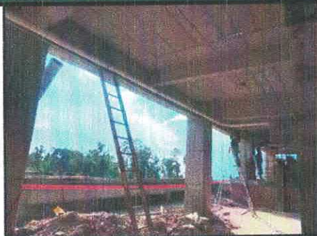
CANALIZACIÓN DE TUBERÍA HIDROSANITARIA N-2 EDIF. "B"
