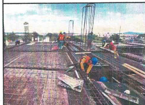
COLOCACIÓN DE CIMBRA EN LOSA AZOTEA EDIF. "B"
