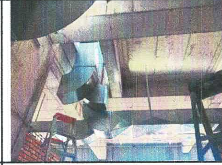
HABILITADO DE DUCTOS DE AIRE ACONDICIONADO N-2 EDIF. "B"
