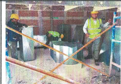
HABILITADO DE DUCTOS PB EDIF. "B"
