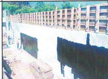
IMPERMEABILIZACIÓN EN MURO DE CONTENCIÓN SECCIÓN 5
