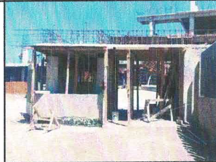
REPELLADO DE MUROS EN CASETA DE VIGILANCIA 2
