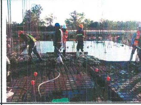
COLADO DE LOSA N-1 EDIF. "C"
