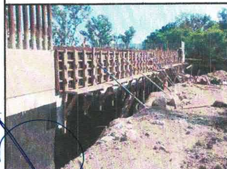
CIMBRADO EN BARDA DE MURO DE CONTENCIÓN SECCIÓN 5
