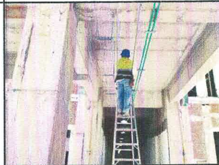
CANALIZACIÓN DE TUBERÍA PARA ALUMBRADO PB EDIF. "A"
