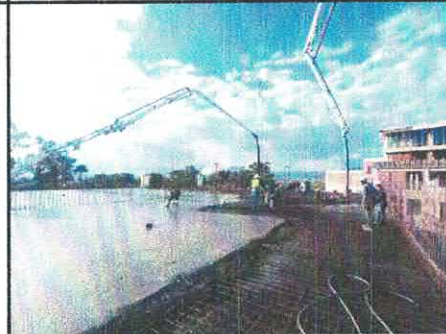
COLADO DE LOSA DE AZOTEA EDIF. "E"
