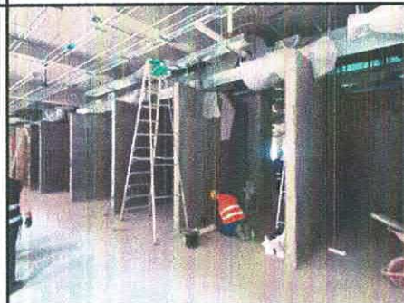
CANALIZACIÓN DE TUBERÍA SANITARIA N-1 EDIF. "B"
