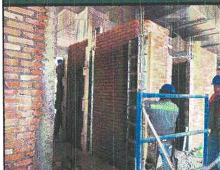
COLOCACIÓN DE CIMBRA PARA CASTILLOS Y DALAS N-2 EDIF. "B"
