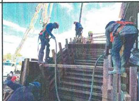
COLADO DE ESCALERAS PB EDIF. "B"
