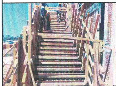
COLOCACIÓN DE CIMBRA EN ESCALERAS PB EDIF. "B"
