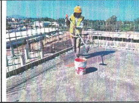
CURADO DE LOSA DE AZOTEA EDIF. "B"
