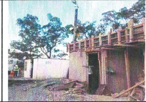
COLADO DE TRABES DE CASETA DE VIGILANCIA 2
