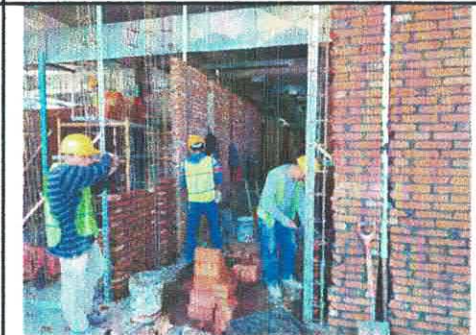
DESPLANTE DE MURO DE TABIQUE ROJO N-2 EDIF. "B"
