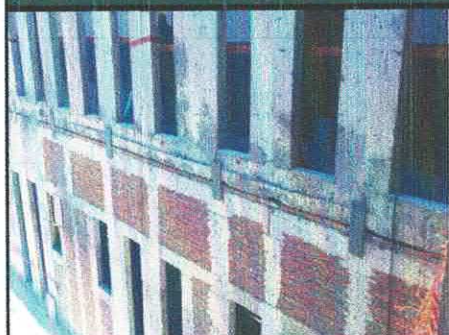
COLOCACIÓN DE ZETAS PARA ANLAJE DE MUROS EN FACHADA N-1 EDIF. "A"
