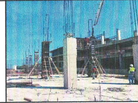
COLADO DE COLUMNAS N-1 EDIF. "C"
