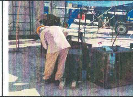
SOLDADURA DE ENCAMISADOS VESTÍBULO PRINCIPAL
