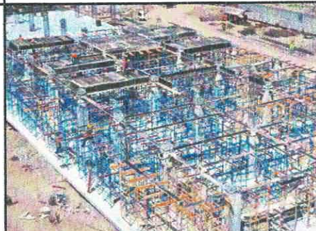
COLOCACIÓN DE CIMBRA EN LOSA DE AZOTEA EDIF. "E"
