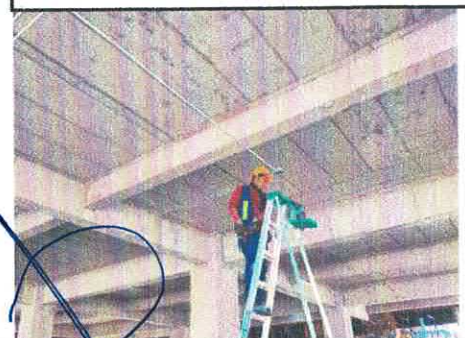
CANALIZACIÓN DE TUBERÍA PARA ALUMBRADO PB EDIF. "C"
