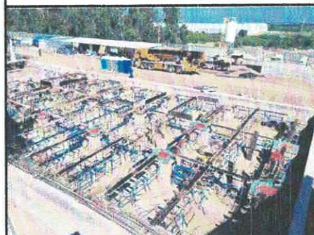
COLOCACIÓN DE CIMBRA PARA TRABES PB EDIF. "E"
