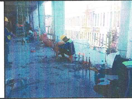
CANALIZACIÓN DE TUBERÍA DE COBRE PARA MUEBLES N-1 EDIF. "B"
