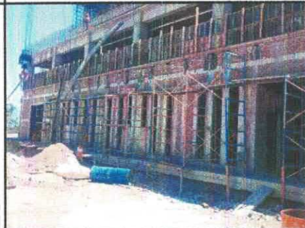
DESPLANTE DE MURO EN FACHADA DE PATIO INTERIOR PB EDIF. "B"
