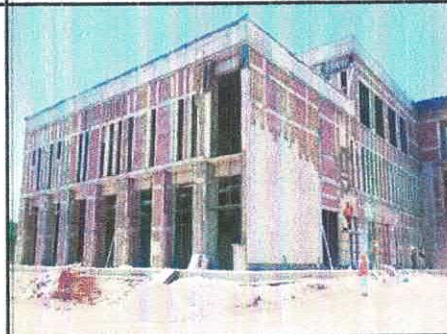
COLOCACIÓN DE CANTERA EN FACHADA NOROESTE EDIF. "A"
