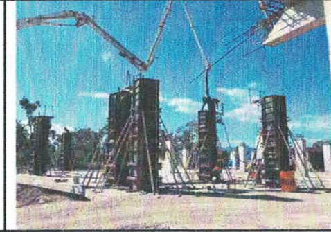
COLADO DE COLUMNAS PB EDIF. "E"
