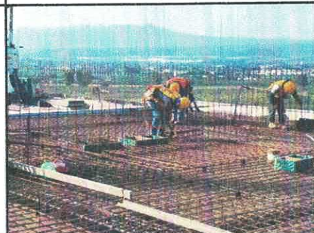
ARMADO DE PARRILLA EN LOSA DE AZOTEA EDIF. "B"
