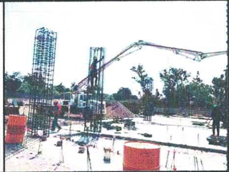
ARMADO DE ACERO EN COLUMNAS PB EDIF. "E"
