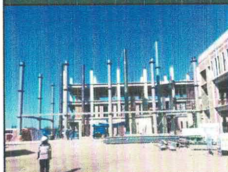
IZAJE Y MONTAJE DE COLUMNAS METÁLICAS VESTÍBULO PRINCIPAL
