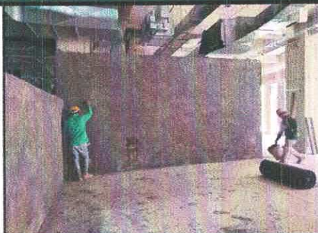
REPELLADO Y APLANADO DE MURO N-1 EDIF. "A"
