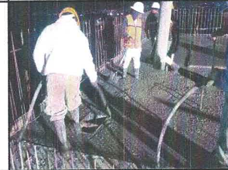
COLADO DE LOSA DE AZOTEA EDIF. "B"
