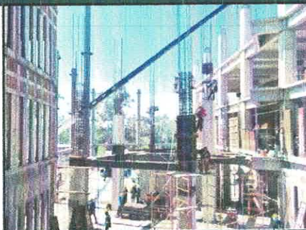
HABILITADO Y ARMADO DE COLUMNAS N-1 VESTÍBULO PRINCIPAL
