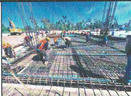
ARMADO DE PARILLA EN LOSA PB EDIF. "E"
