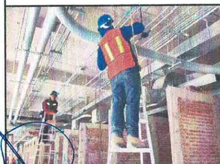
CANALIZACIÓN DE TUBERÍA PARA CORREO NEUMÁTICO PB EDIF. "B"
