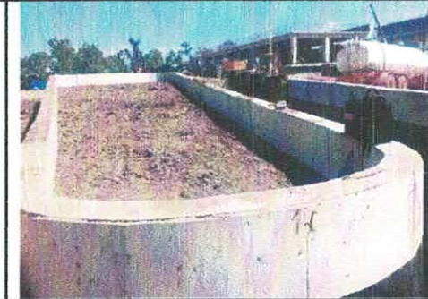
ACARREO, MEJORAMIENTO Y COMPACTACIÓN EN RAMPA
