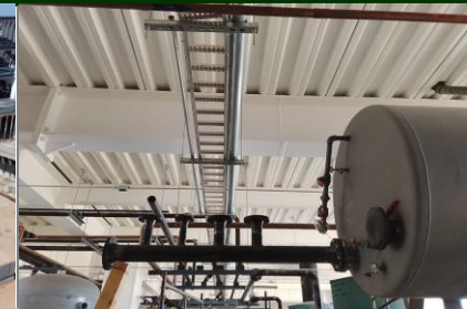
Colocación de charola para canalización de
