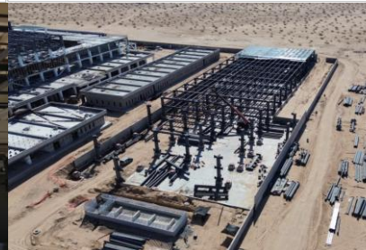
Montaje de estructura metálica en Cuerpo de Estacionamiento
