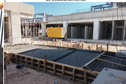
Cimbra y habilitado de acero para losa en tunel de servicio Obras Exteriores
