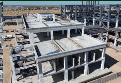
Montaje de escaleras de servicio y colado de pretilas en
