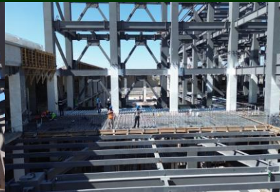
Habilitado de acero en entrepisos y muro perimetral,
