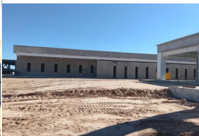
Relleno y compactación en terracerías en Obras Exteriores
