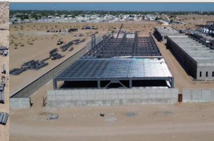
Colocación de losacero y colado de entrepiso en cuerpo de Estacionamiento
