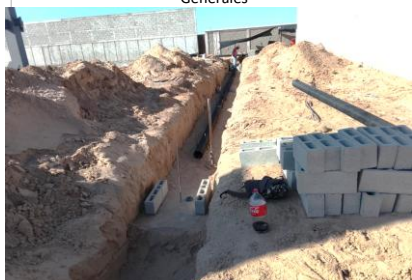
Tendido de tubería sanitaria en Obras Exteriores
