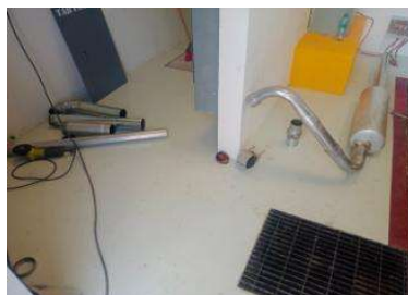
SUMINISTRO Y COLOCACION DE MOFLE PARA PLANTA DE EMERGENCIA
