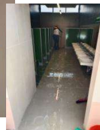
LIMPIEZA FINA Y AJUSTE DE ALARME DE SISTEMA CONTRA INCENDIOS
