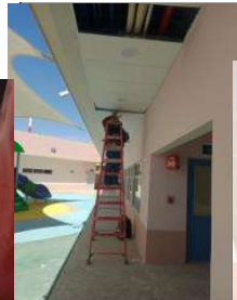
SUMINISTRO Y COLOCACION DE REGISTROS EN PLAFONES DE COCINA Y DE SANITARIOS
