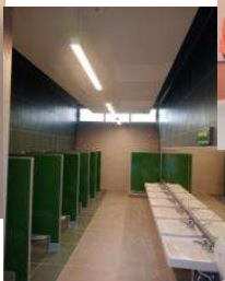
SUMINISTRO Y COLOCACION DE REGISTROS EN PLAFONES DE COCINA Y DE SANITARIOS
