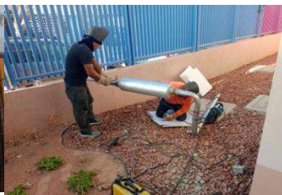
SUMINISTRO Y COLOCACION DE MOFLE PARA PLANTA DE EMERGENCIA
