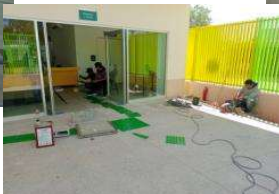
SUMINISTRO Y COLOCACION DE GUIA PODOTACTIL
