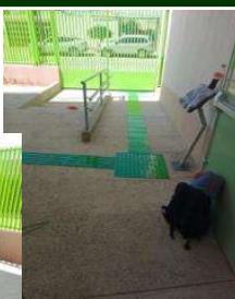
SUMINISTRO Y COLOCACION DE GUIA PODOTACTIL
