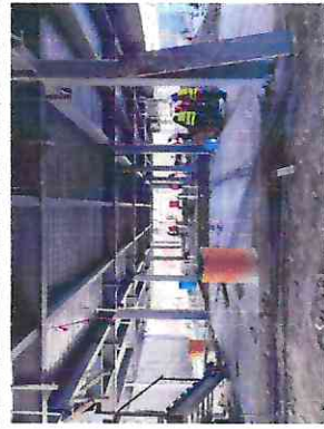
Armado de acero en firme para recibir concreto
