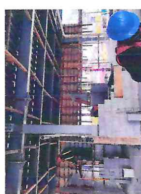
Continúan trabajos de albanilería, colocación de block, instalación de Ductos de A/A, colado de dalas de castillos, colados de dalas, colado de firmes y preparación de juntas de expansión
