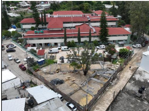
AREA DE COCINA RUSTICA
