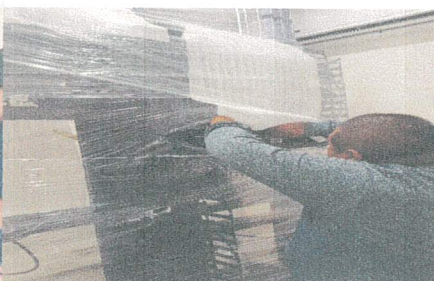
TRABAJOS DE TELECOMUNICACIONES FUSIONANDO
