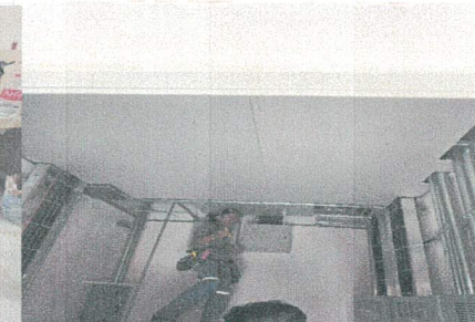
COLOCACION DE PLAFON EN CUARTO ELECTRICO DEL CUERPO 2 ENCAMADOS
