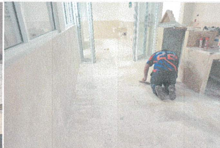
EMBOQUILLADO Y LIMPIEZA MARMOL AREA DE PEDIATRIA
