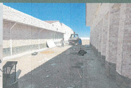
LIMPIEZA GENERAL PARA NIVELACION DE PISO PARA JARDINERIA INTERIOR CUERPO 4 Y 2
