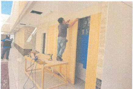
COLOCACION DE CLOSET AREA DE TABLEROS
