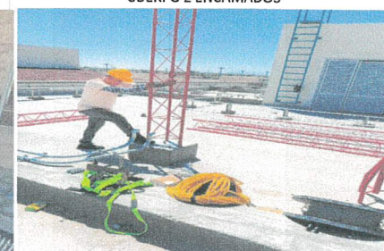
INSTALACION DE TORRE DE RADIOCOMUNICACION EN AZOTEA
