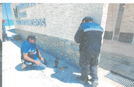
TRABAJOS DE ALUMBRADO EN LETRERO DE LA OBRA
