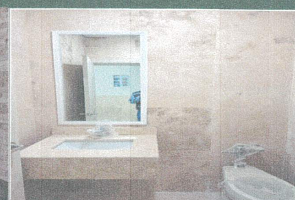
COLOCACION DE ESPEJOS EN AREA DE SANITARIOS
