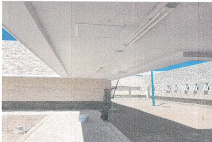
PINTURA EN PLAFONES AREA EXTERIOR DE CUERPO 1
