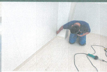
SOLDADO Y SELLADO DE PISO DE VINIL Y ZOCLO AISLADOS URGENCIAS
