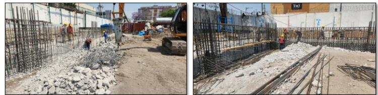
Descabezado de muro milán y armado de trabe de coronamiento.
