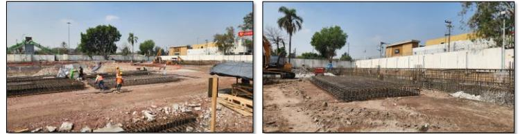
Habilitado y armado de acero de los módulos del muro milán.
