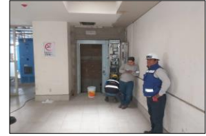
INSPECCIÓN FÍSICA Y TÉCNICA DE MONTACARGAS DE 2 ESTACIONES UBICADO EN LA NUEVA CENTRAL DE SERVICIOS.
