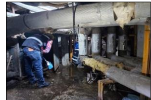
INSPECCIÓN FÍSICA DE LOS PUNTOS DE INTERCONEXIÓN CORRESPONDIENTES AL HOSPITAL DE INFECTOLOGÍA CON LA NUEVA CENTRAL DE SERVICIOS.
