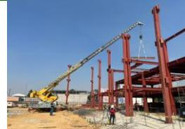
Montaje de los elementos estructurales de acero del edificio principal.
