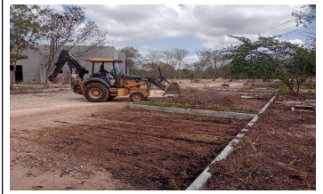
LIMPIEZA DE ÁREAS EXTERIORES RETIRANDO BASURA, MALEZA Y TIERRA
