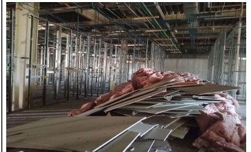
DESMANTELAMIENTO DE BASTIDOR DE PERFIL METÁLICO Y MURO DE TABLAROCA A UNA CARA EN PRIMER NIVEL DE EDIFICIO PRINCIPAL
