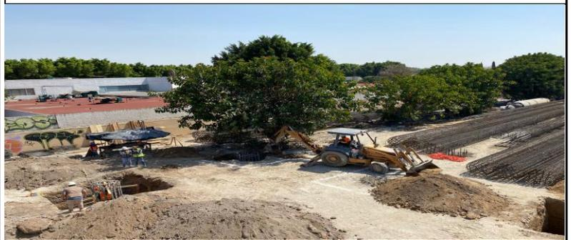
INICIO DE EXCAVACION DE CEPAS PARA CONSTRUCCION DE DADOS DE CIMENTACION
