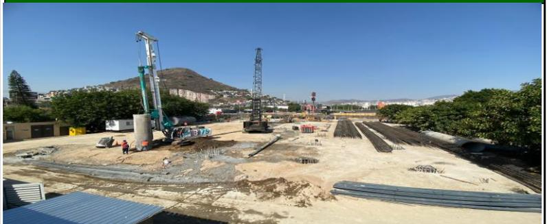
VISTA PANORAMICA DEL AREA DE TRABAJO COLOCACION DE ADEME EN PERFORACION PARA PILA P2
