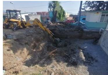
Excavación para dar nivel a nueva cisterna.
