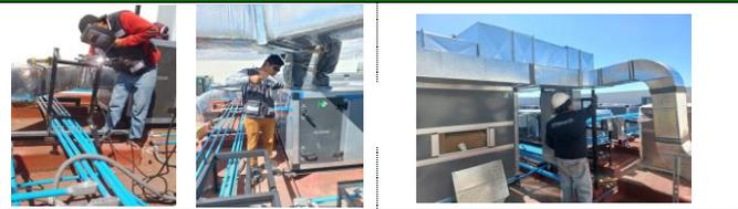
DE LOS EQUIPOS DE A.A. EN LA PLANTA DE AZOTEA SE ESTAN COLOCANDO UNAS CASETAS PARA LOS HUMIDIFICADORES
