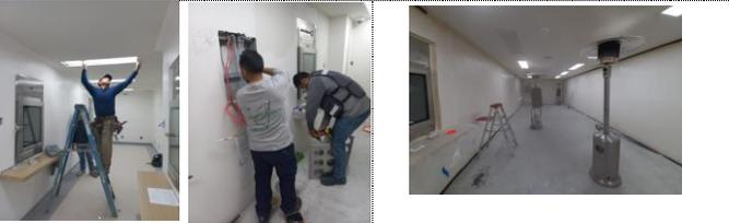
CONTINUAN COLOCANDO LUMINARIAS Y MARCOS PERIMETRALES DE T ESMALTADA, COLOCACION DE DETECTORES DE PRESENCIA Y COLOCACION DE TAPAS EN CONTACTOS-SUMINISTRO Y COLOCACION DE GABINETES DE MANOMETROS PARA MEDIR PRESION
