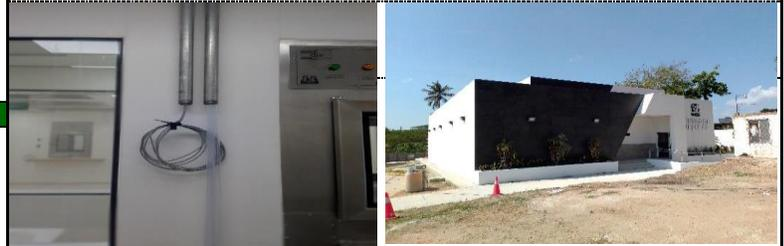
CANALIZACIONES Y CABLEADO PARA MONITOREO DE SISTEMA HVAC
