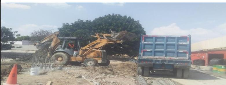
SE REALIZA RETIRO DE MATERIAL PRODUCTO DE EXCAVACION DE PILAS MEZCLADO CON ADOPOL POLIMERO BIODEGRADABLE.
