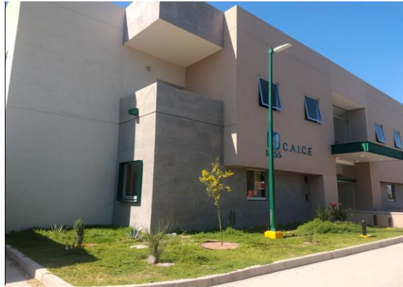
Situación actual de la obra:
