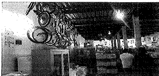
Foto 2.- Interior de edificación sistema viga-columna y losa- acero (vista 1)
