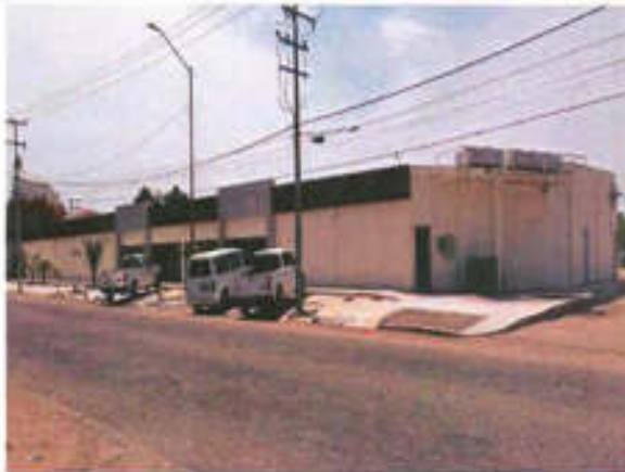
Vista de fachada principal
