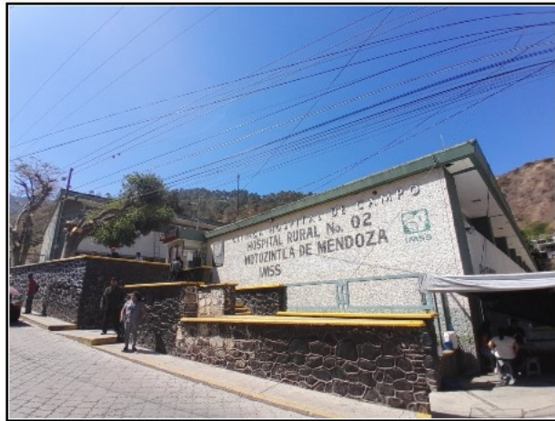
VISTA DE FACHADA DEL ACTIVO EN ESTUDIO
