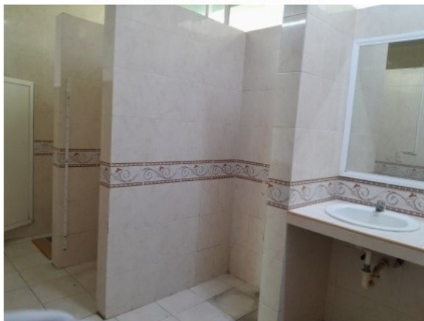
VISTA INTERIOR BAÑO
