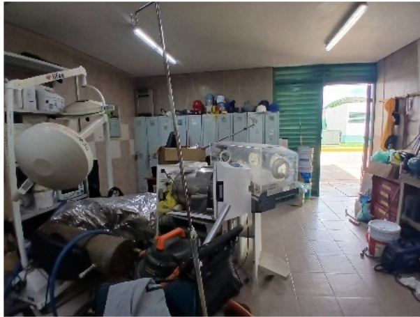
TALLER DE MANTENIMIENTO
