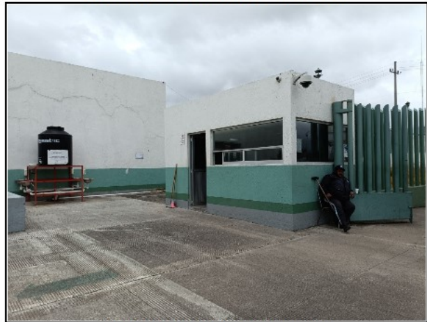
CASETA DE VIGILANCIA ACCESO
