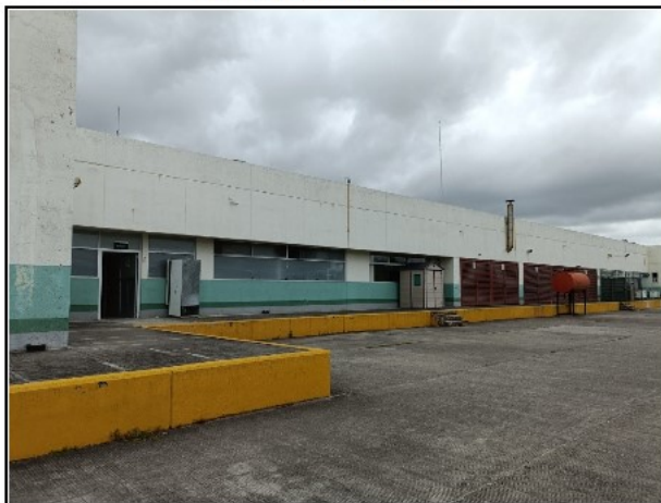
PATIO DE MANIOBRAS
