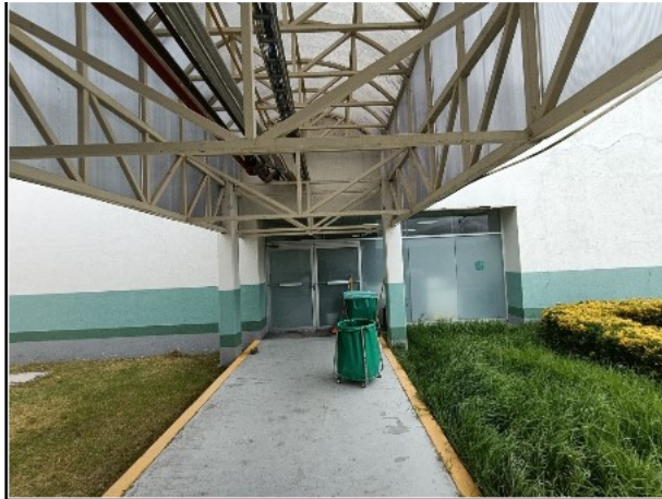
PASO A CUBIERTO
