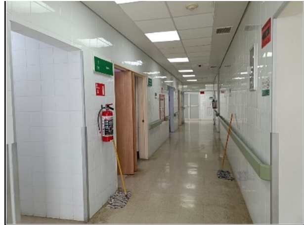
PASILLO INTERIOR URGENCIAS
