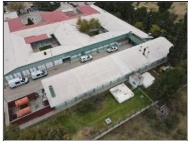
VISTA AÉREA HOSPITAL
