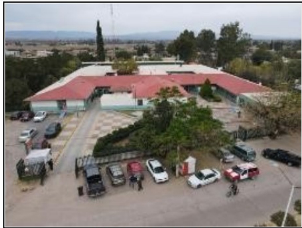
VISTA AÉREA HOSPITAL
