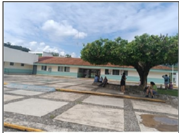
Vista exterior del activo
