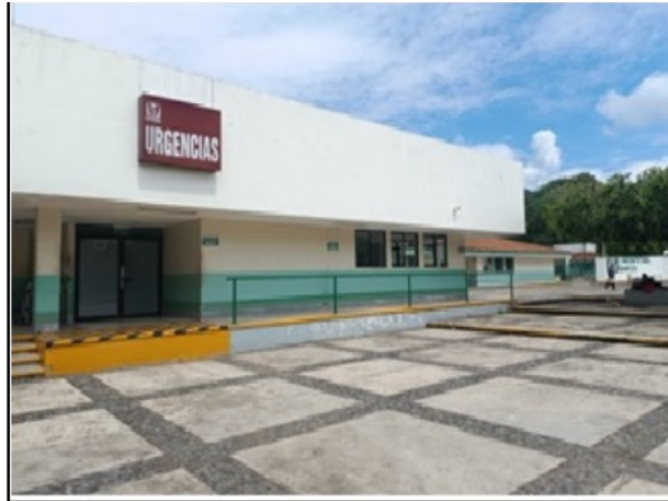
Vista exterior del activo
