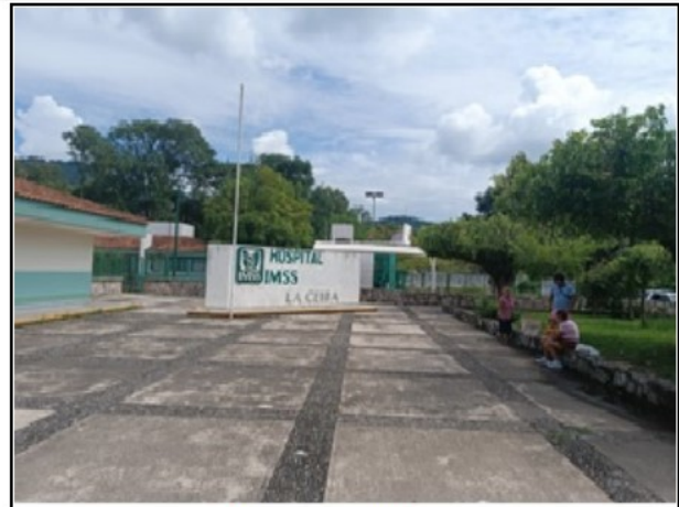
Vista exterior del activo
