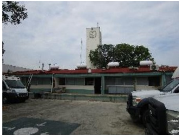
Vista general hacia el área de lavandería y cocina
