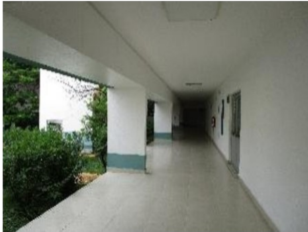
Vista general de los pasillos del activo en estudio
