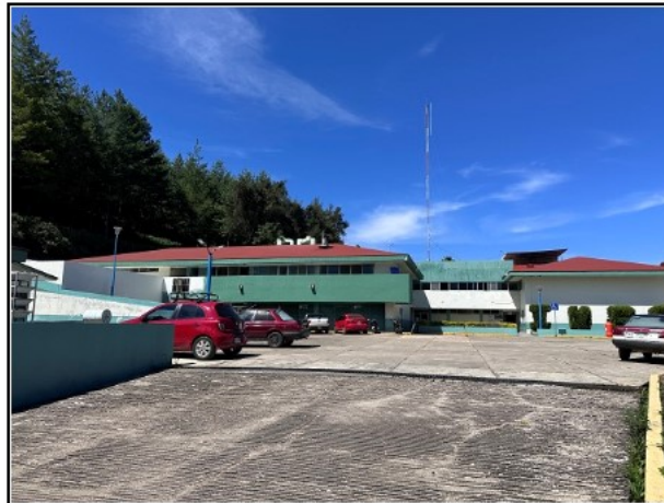
1.- VISTA DE LA FACHADA DEL ACTIVO.
