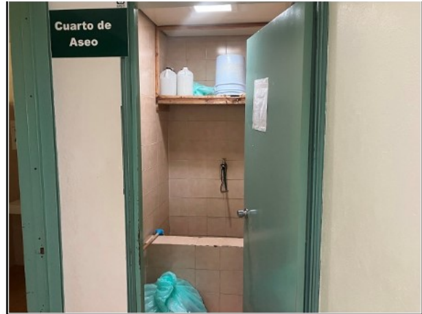
36.- INTERIOR DEL CUARTO DE ASEO.
