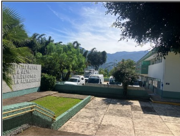
110.- VISTA DE LA FACHADA LATERAL DEL HOSPITAL.
