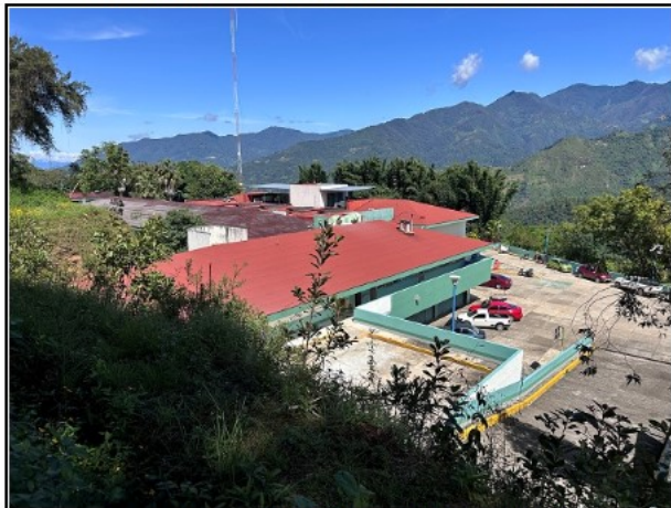
118.- VISTA DEL TECHADO DEL HOSPITAL.
