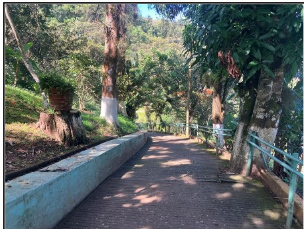
107.- VISTA DE LA RAMPA DE ACCESO.
