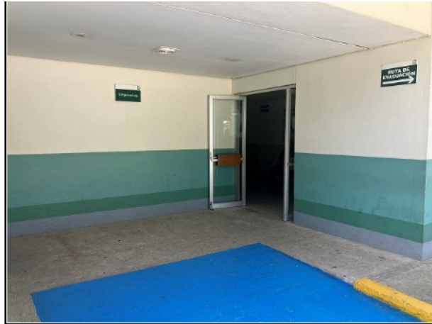
77.- AREA DE ACCESO AL AREA DE URGENCIA.
