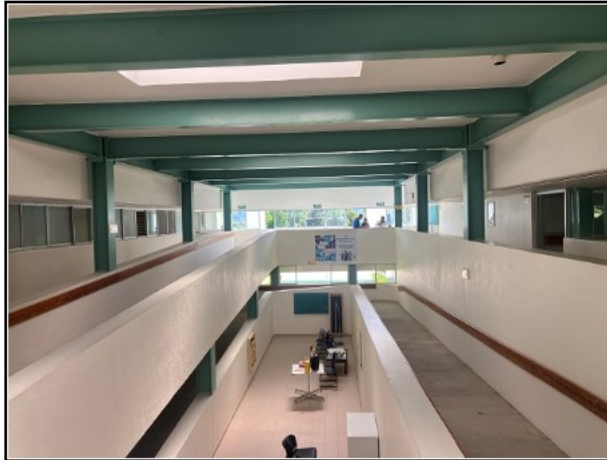
37.- RAMPA DE ACCESO PARA DISCAPACITADO.
