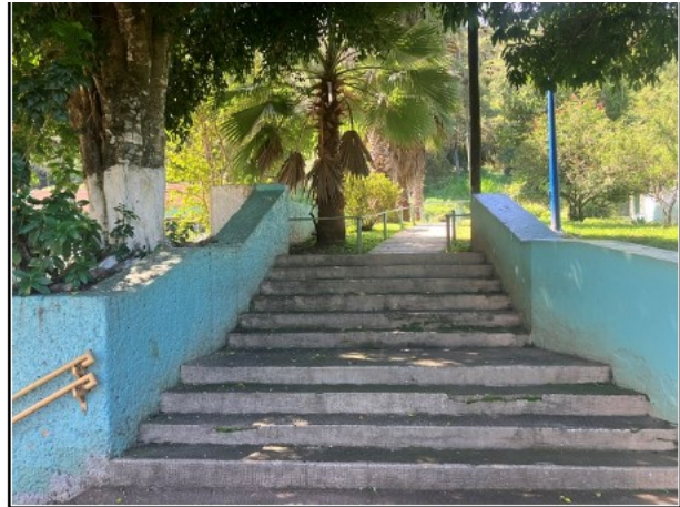
109.- VISTA DE LOS ESCALONES DE ACCESO.
