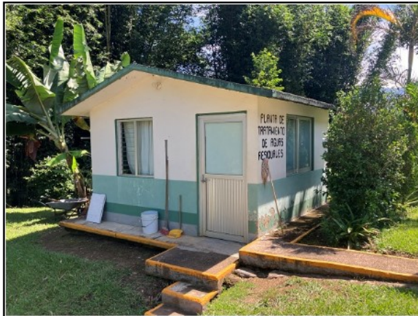
104.- CASETA DE LA PLANTA DE TRATAMIENTO.
