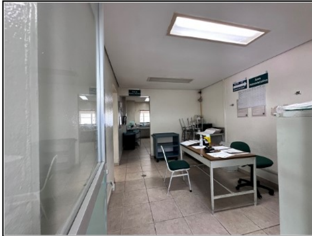
152.- VISTA DEL AREA ADMINISTRATIVA DEL COMEDOR.
