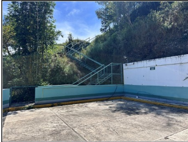
116.- ESCALERAS DE ACCESO AL HELIPUERTO.
