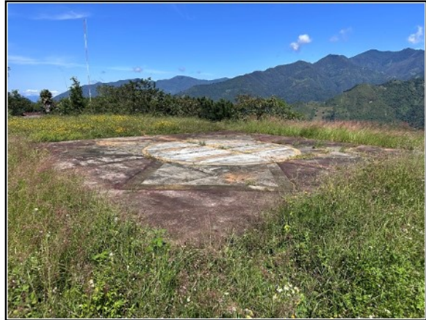
117.- VISTA DEL HELIPUERTO.
