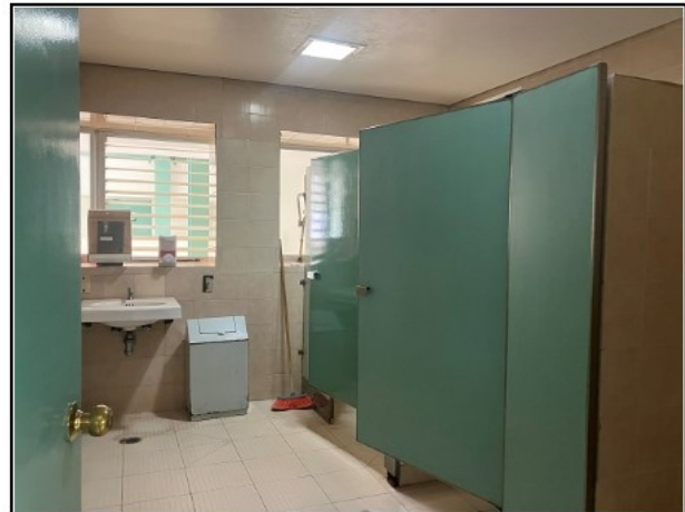
50.- INTERIOR DEL BAÑO DE HOSPITALIZACION.
