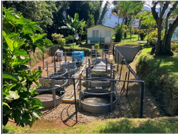
102.- VISTA DEL TANQUE ESTACIONARIO.
