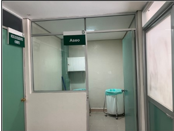
43.-ACCESO AL AREA DE ROPA SUCIA.
