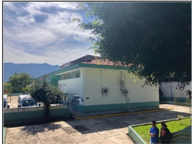
111.- VISTA DE LA FACHADA POSTERIOR DEL HOSPITAL.
