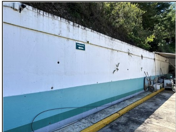
119.- TOMA DE LA BARDA SOBRE LA CALLE DE ACCESO.
