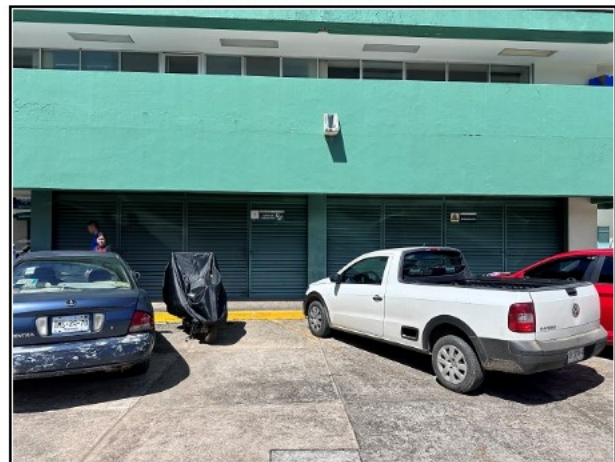
137.-ACCESO A CASA DE MAQUINAS Y SUBESTACION.
