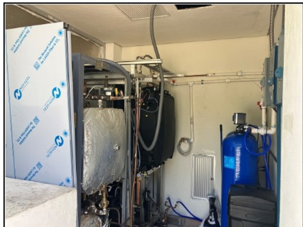
101.- INTERIOR DE LA BODEGA.
