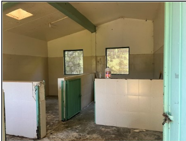
122.- INTERIOR DEL CUARTO DE LA BASURA COMÚN.
