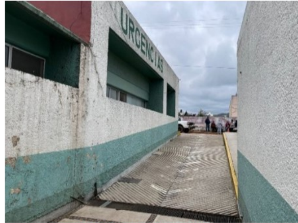
VISTA ACCESO URGENCIAS
