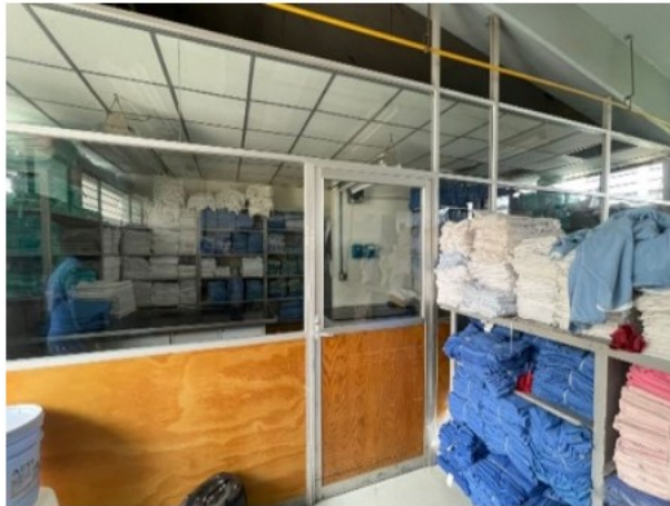
VISTA ÁREA DE LAVANDERÍA
