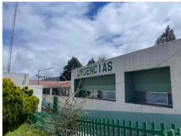
VISTA ACCESO URGENCIAS
