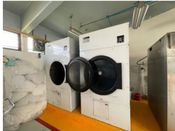
VISTA ÁREA DE LAVANDERÍA
