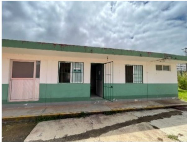
VISTA EDIFICIO DE ALBERGUE
