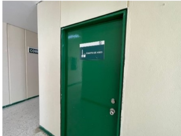
VISTA CUARTO DE ASEO
