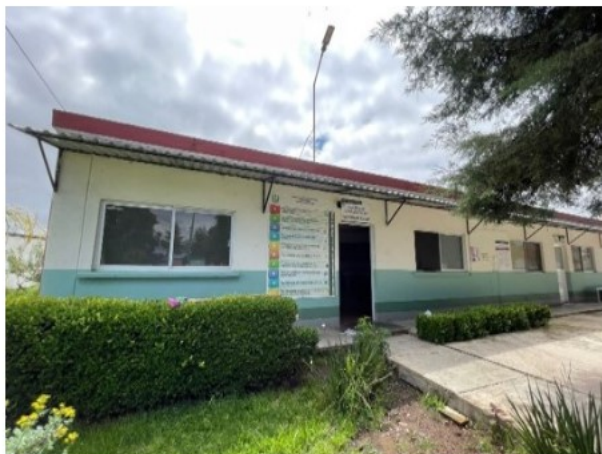
VISTA EDIFICIO DE ALBERGUE
