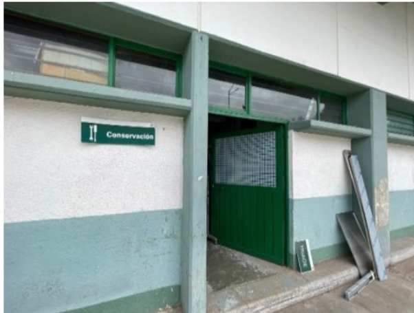
VISTA ÁREA DE CONSERVACIÓN
