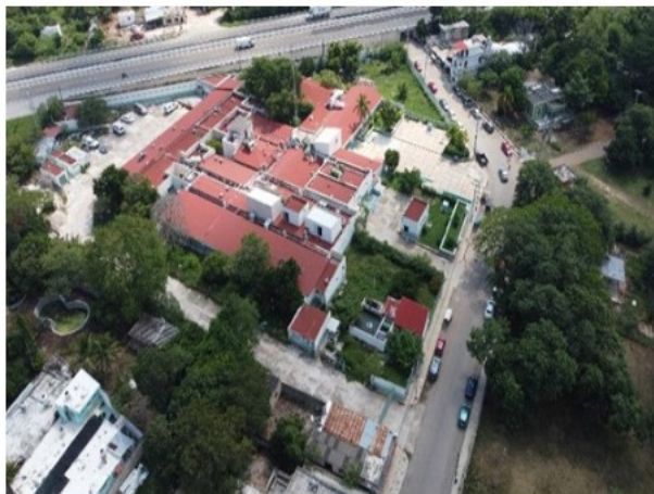
VISTA AÉREA DEL ACTIVO
