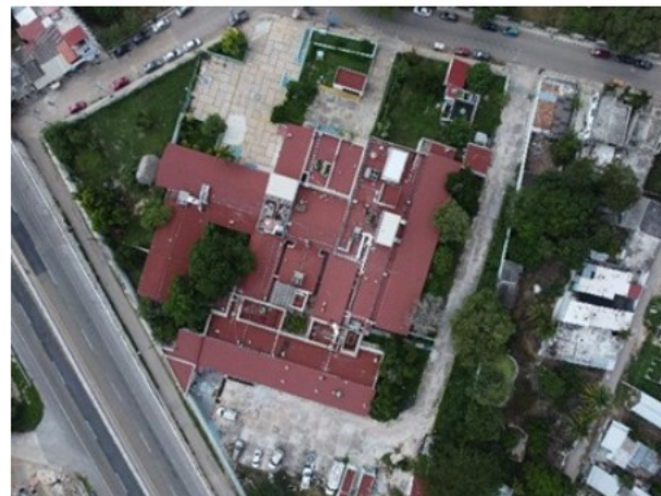
VISTA AÉREA DEL ACTIVO
