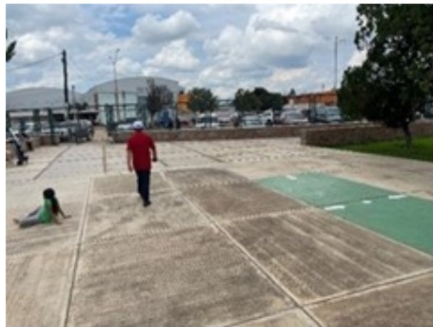
FIRME DE CONCRETO-ANDADORES
