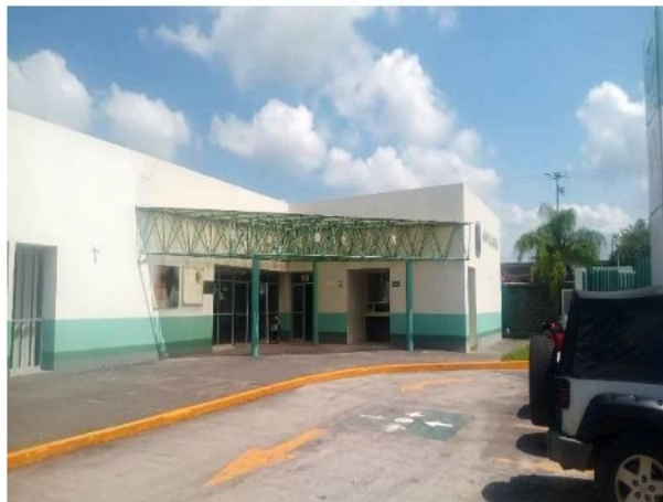
Fachada principal vista al norte
