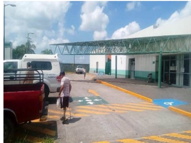
Fachada principal vista al sur
