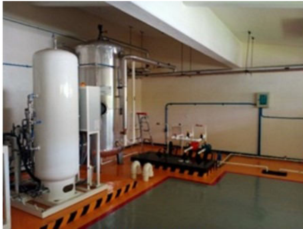
CASA DE MAQUINAS
