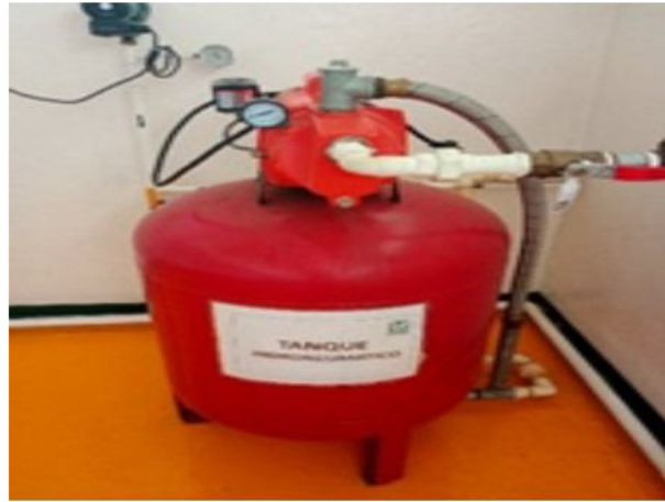
TANQUE HIDRONEUMÁTICO
