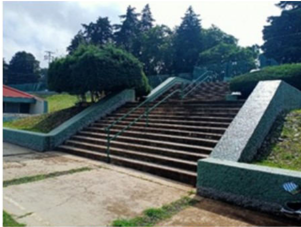
ESCALINATA DE ACCESO
