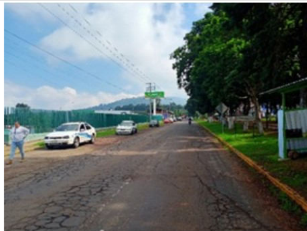
VISTA EXTERIOR SOBRE CALLE ALATRISTE
