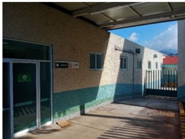
ACCESO VEHICULAR - URGENCIAS
