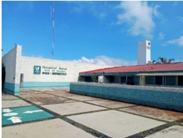
VISTA PANORÁMICA - PATIOS Y TANQUE ELEVADO
