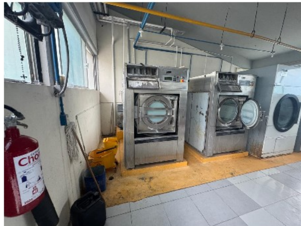
VISTA DE LAVANDERIA
