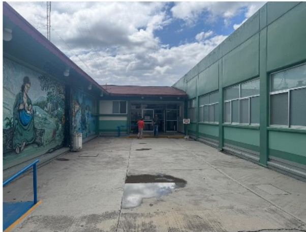
VISTA DE ACCESO PRINCIPAL
