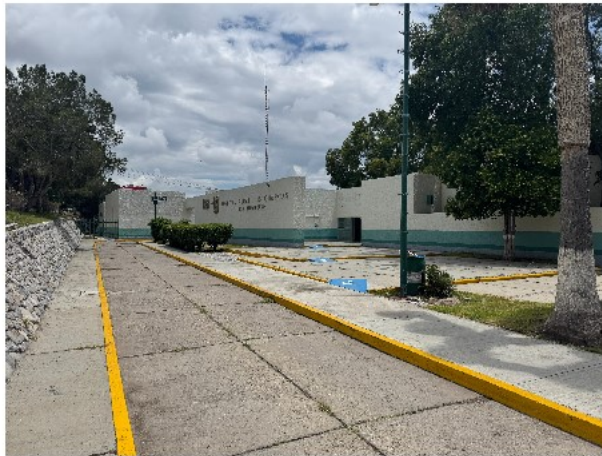
VISTA DE FACHADA PRINCIPAL
