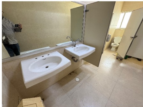
VISTA DE SANITARIOS
